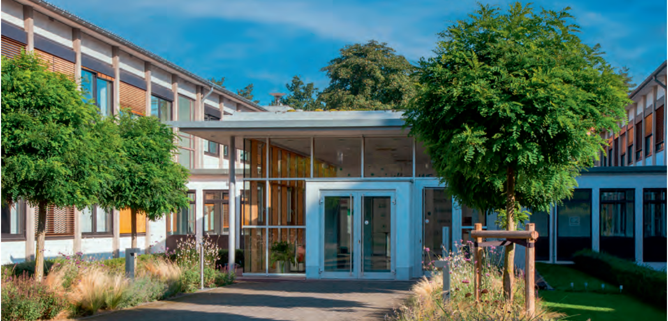
↑ Eingang Fraunhofer IAIS
